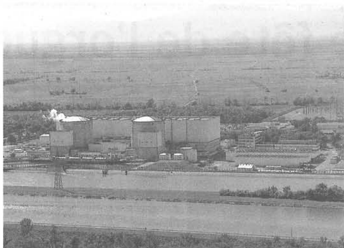
Vue aérienne de la centrale de Fessenheim prise depuis l'Allemagne. (Photo archives - Bernard Schmidlé)
